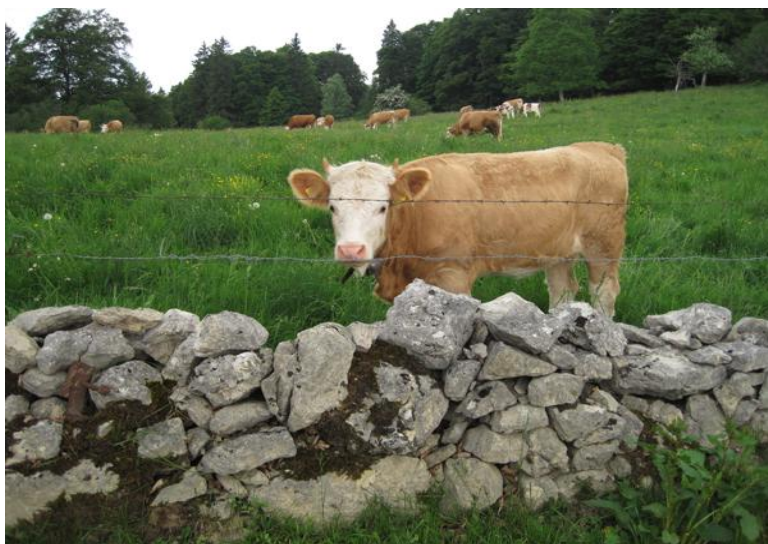
Mur de pierres sèches
